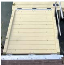
Befestigung der Zugangsbrücke am Kai
