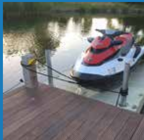
Verankerung an Schraubpfählen
