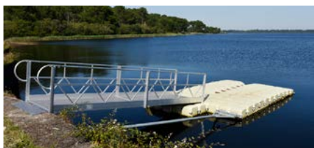
Befestigung der Zugangsbrücke am Kai
