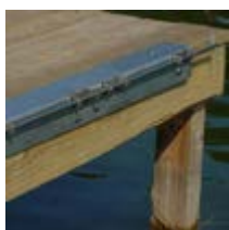
Bevestiging van de loopbrug aan de oever
