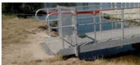
Fixation de la passerelle à la berge
