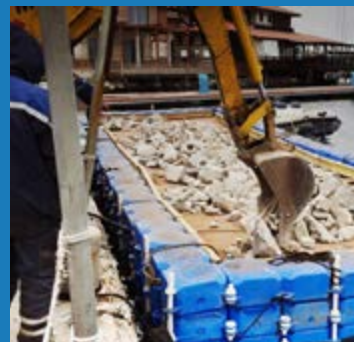
Travaux de maintenance
