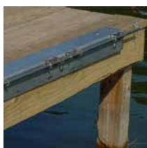
Befestigung der Zugangsbrücke am Kai
