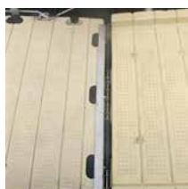
Befestigung der Zugangsbrücke am Ponton
