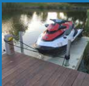
Verankering op schroefpaal
