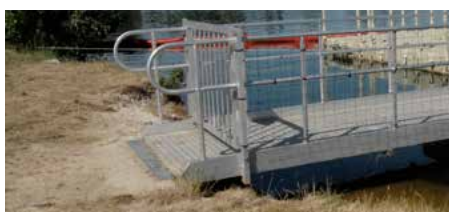
Befestigung der Zugangsbrücke am Kai
