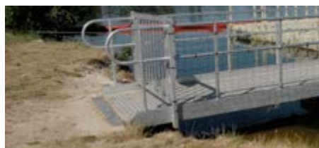
Bevestiging van de loopbrug aan de oever
