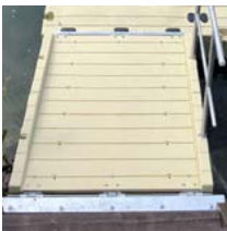
Bevestiging van de loopbrug aan de oever
