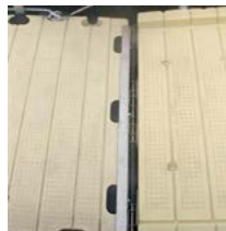
Bevestiging van de loopbrug aan de steiger
