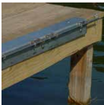
Fixation de la passerelle à la berge
